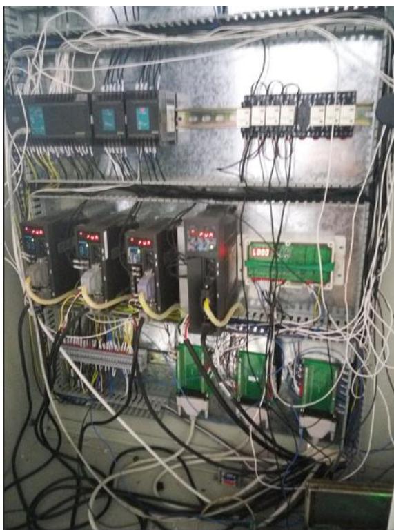
图 6-2 电气柜的实物接线图
